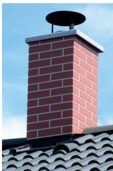
Облицовка кирпичной плиткой HELUZ
